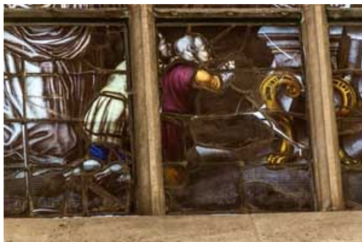
Oude Kerk, Detail van het Crabethraam (1555) met gebroken en uit het lood hangend gebrandschilderd glas (foto: Wim Ruigrok, november 2018)
