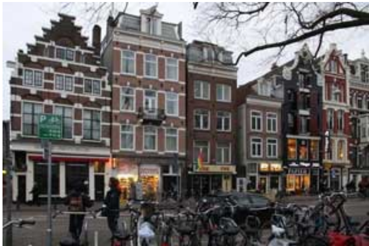
Achter deze gevelwand van de Amstel bij de Halvemaansteeg moet een groot uitgaanscomplex komen (foto: Walther Schoonenberg)
